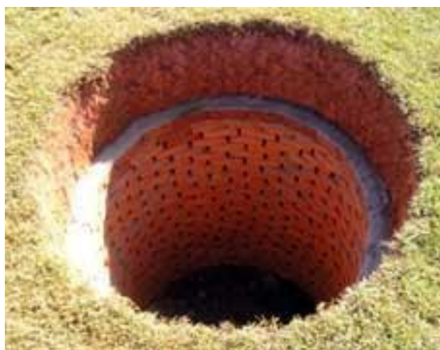
Figura 114 – Tipologia de sumidouro: sumidouro de tijolo
