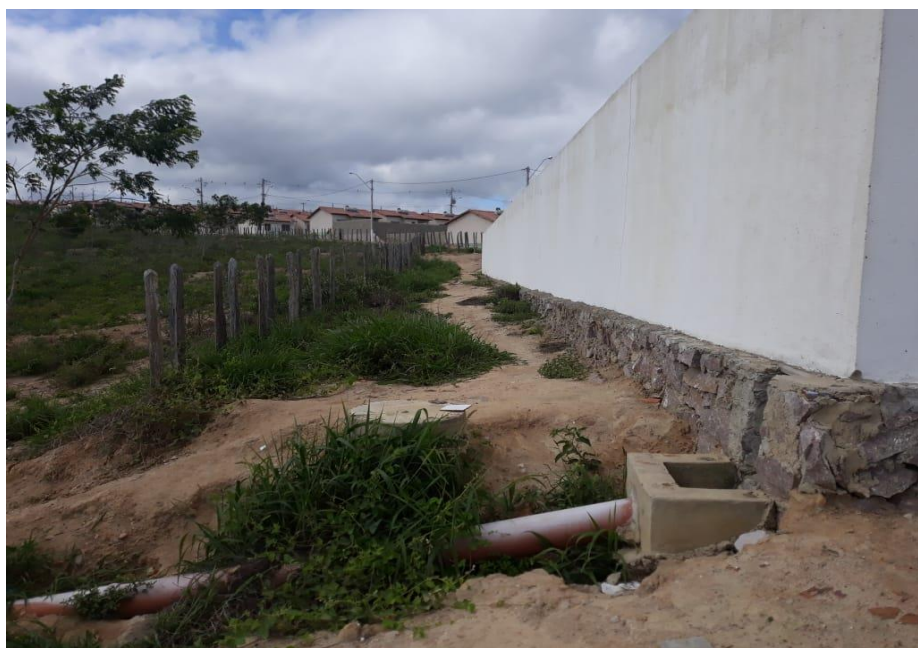
Figura 54 – Poço de visita do emissário da ETE de Lajedinho
