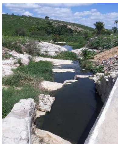
Figura 63 – Rio Saracura a jusante da Sede Municipal de Lajedinho
