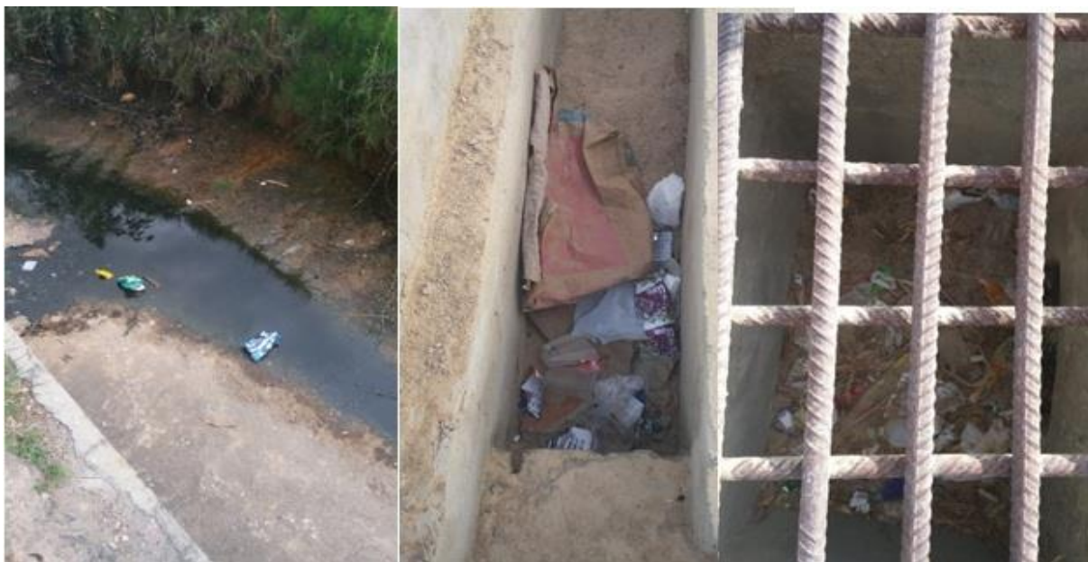
Figura 78 – Acúmulo de resíduos nos canais rio Saracura e nas suas galerias pluviais
