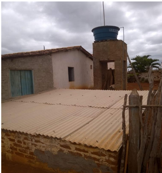
Figura 44 – Cisterna e reservatório de um dos domicílios em Sisal
