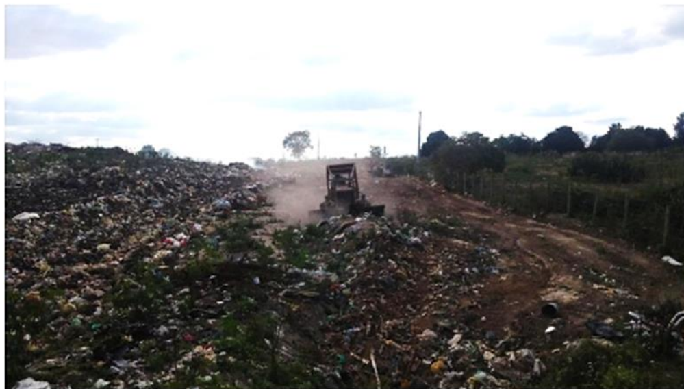
Figura 86 – Início das atividades de adequação do local de disposição final
