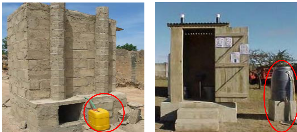
Figura 127 – Bombonas de armazenamento temporário, à esquerda, e de estocagem, à direita, em sanitários com separação de urina implantados em países da África
