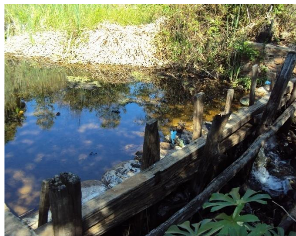
Figura 36 – Estrutura de captação do SAA da Embasa – Lajedinho/BA.
