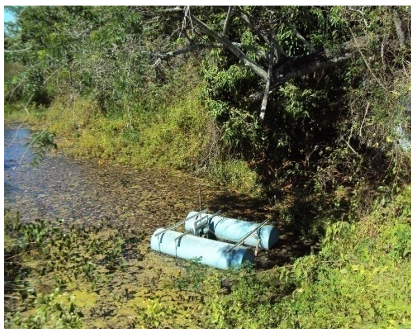
Figura 36 – Estrutura de captação do SAA da Embasa – Lajedinho/BA.
