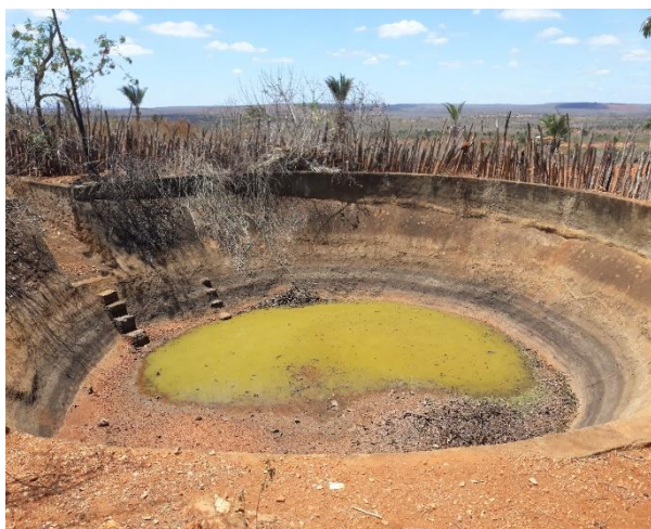
Figura 64 – Aguada para armazenamento de água de chuva e dispositivos de macrodrenagem nas estradas de Lajedinho/BA
