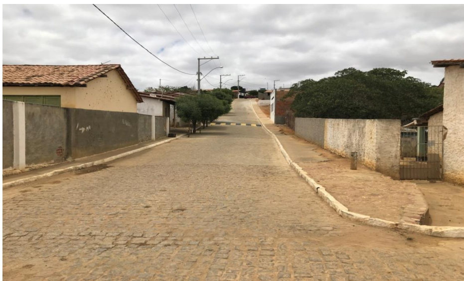
Figura 71 – Via Pavimentada na Localidade de Arrecifes, distrito de Lajedinho/BA
