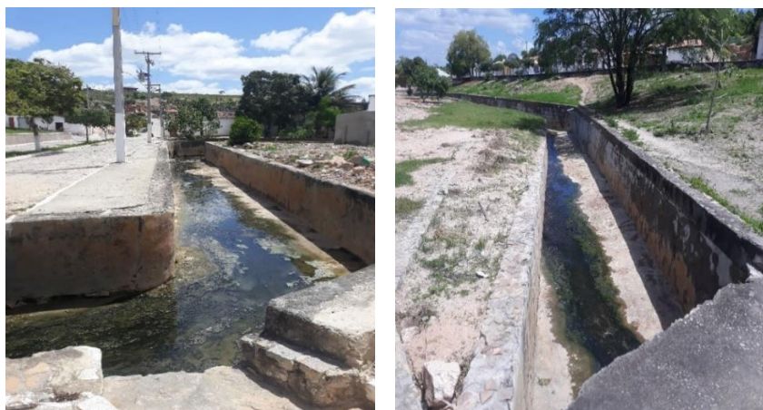
Figura 62 – Trecho canalizado do Rio Saracura na Sede Municipal de Lajedinho
