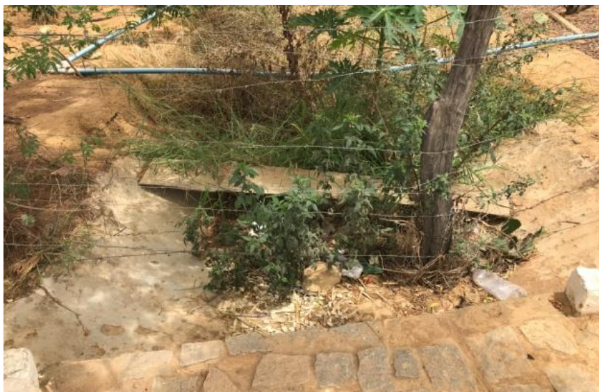
Figura 68 – Ponto de formação de voçoroca
