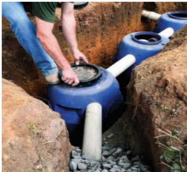
Figura 120 – Instalação das fossas sépticas econômicas
