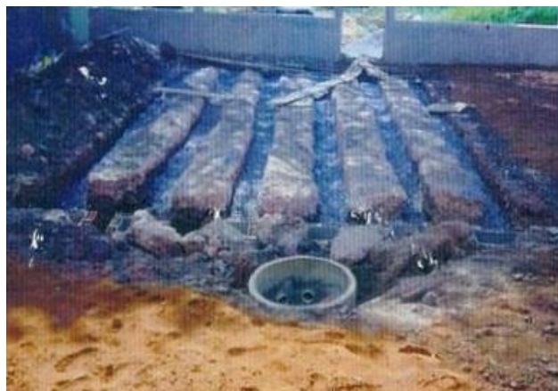
Figura 113 – Valas de infiltração construídas e esquema do leito filtrante
