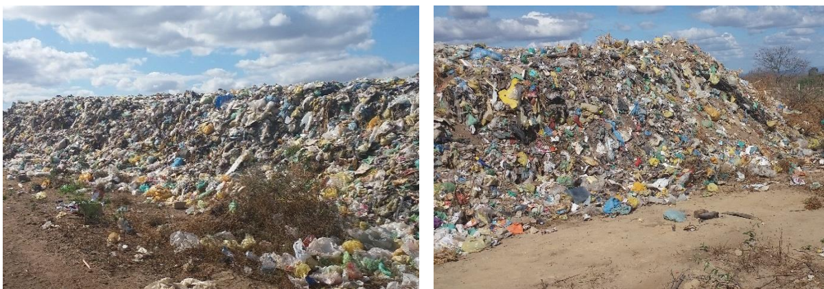
Figura 79 – Resíduo empilhado com talude de alturas oscilando entre 2,0m a 3,5m
